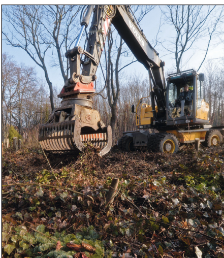
Ein Bagger räumt die Fläche.
